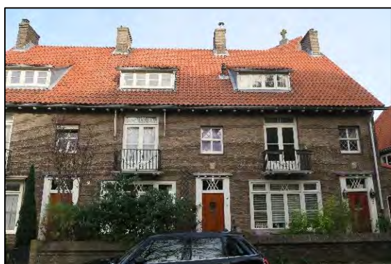
32 Woningen aan de Garenkokerskade.
