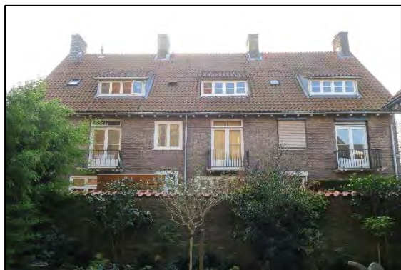
33 Achtergevels, aan de zijde van de binnenplaats.
