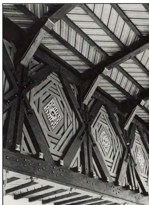
42 Detail kerkzaal 1938 (NHA, anon., 1100, 7713).
