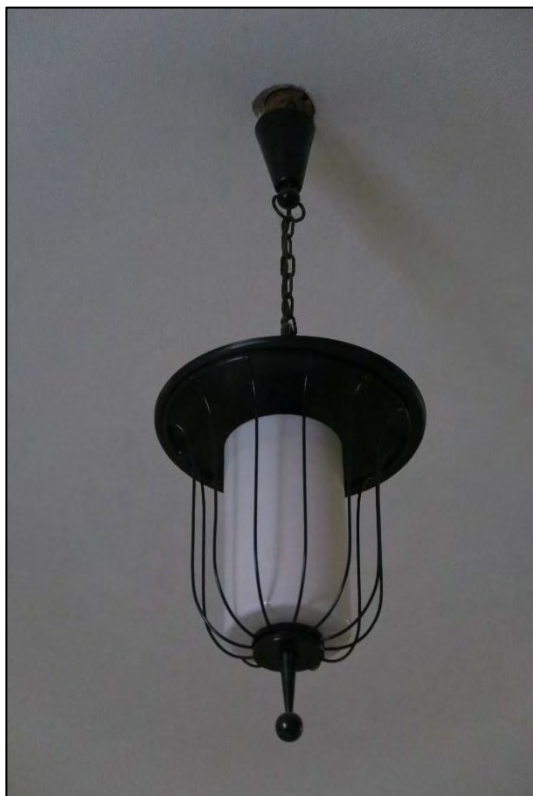
86 Eén van de originele lampen in de toegangshal op de begane grond.
