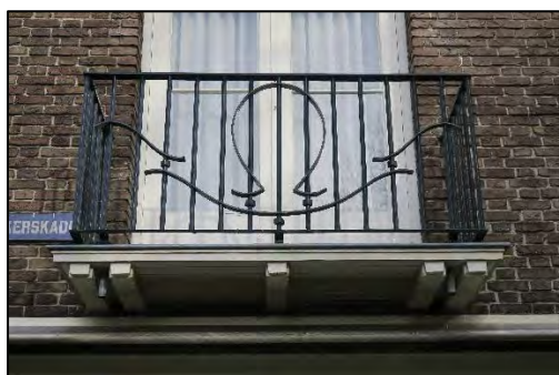
16 Eén van de sierlijk gesmede balkonhekken.
