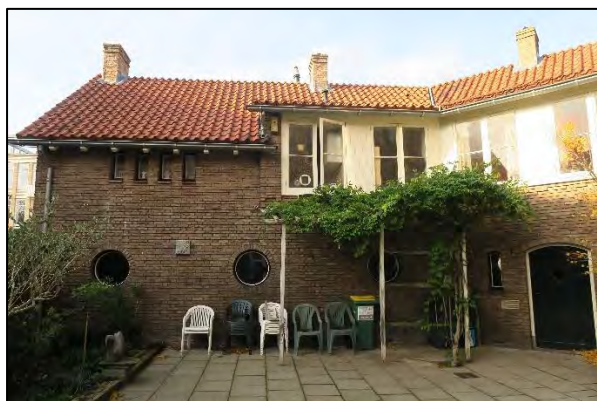
63 Achterzijde kosterswoning, met oculi garageboxen.
