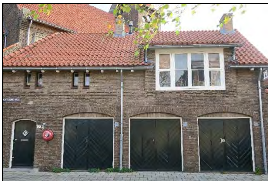
30 Garageboxen en daarboven de kosterswoning.
